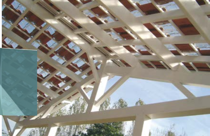
Avant toit pour maison de particuliers / Olonnes sur mer
